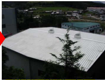
遮熱塗料+光触媒施工直後
