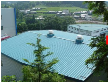
施工前の折板屋根の状況
