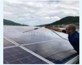
光触媒を主成分とする耐水かつ導電塗膜が形成され藻の繁殖抑制効果。熱帯雨林気候での研究所にて促進耐候性試験の検証効果が認められており、汚れによる発電量の低下を防ぐことができます。更に氷と雪の融点を下げ融解させる付加的&便利な性能も。原理としては道路の融雪剤と同様のため傾斜して設置されたパネルに施工した場合、積雪が傾斜に沿って自然に落下しやすくなります。
