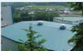
施工前の鋼板屋根
