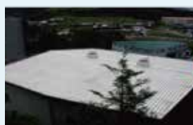
白の遮熱塗料+NFE2光触媒施工
