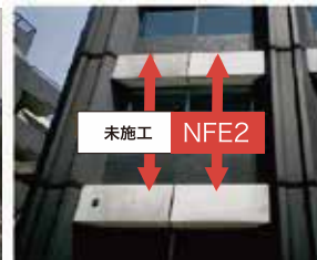
高圧洗浄機で清掃後施工 60ヶ月後
