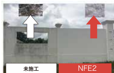
ペンキを塗った壁に施工 24ヶ月後
