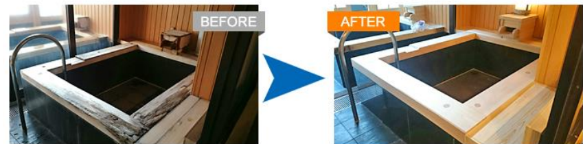
光触媒コーティングでの木材保護の基本イメージと事例
