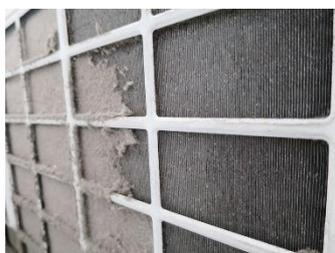
とくに室外機のラジエーターフィンに堆積するホコリはエアコンの効率を顕著に落としますがこの現象を大きく改善することができます。
