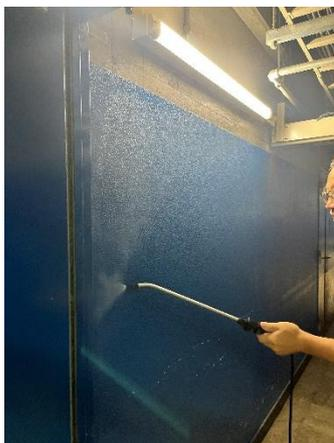
壁面への施工:浮遊している臭気ガスを効率よく分解するためには明るい照明が光触媒に必須ですので、照明に近い壁面にはとくに念入りな重ね塗りをしました
